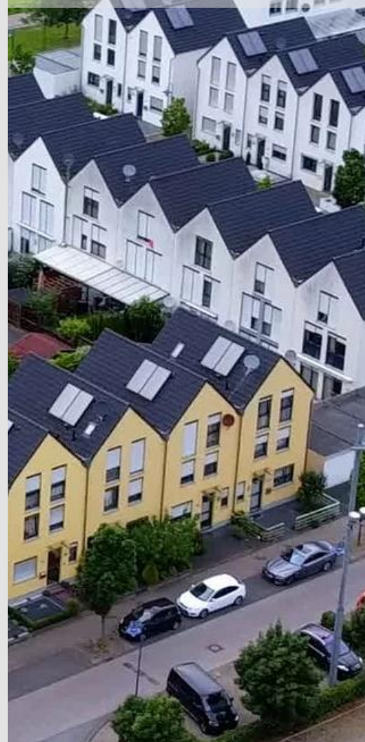
Abb. 6: Wohnungsneubau (Anna-Park, Alsdorf, NRW)
