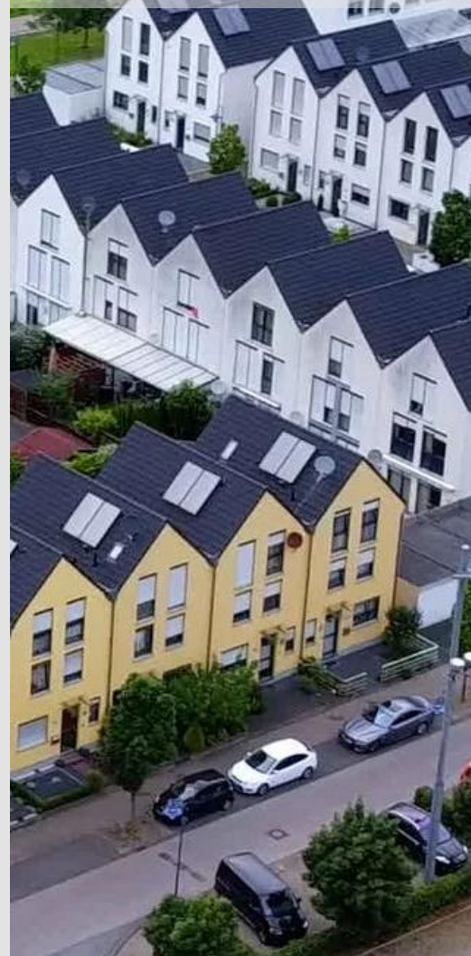
Abb. 6: Wohnungsneubau (Anna-Park, Alsdorf, NRW)
