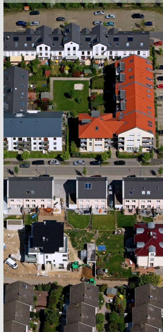
Abb. 4: Wohnungsneubau (Hochschulviertel, Rheinbach, NRW)
