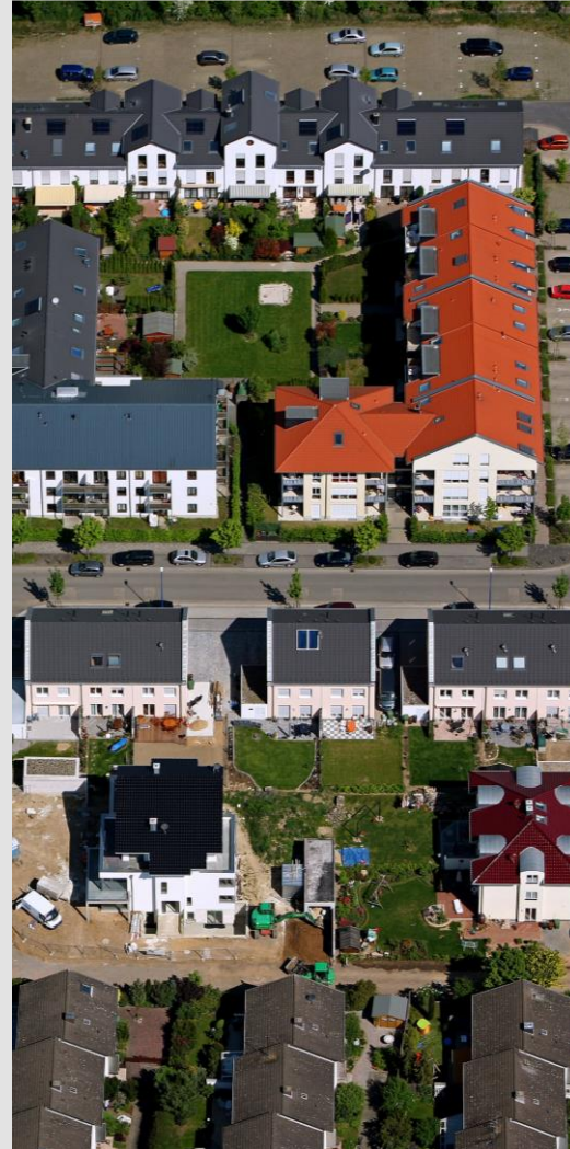
Abb. 4: Wohnungsneubau (Hochschulviertel, Rheinbach, NRW)
